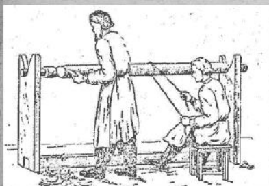
Древнеегипетский токарный станок приблизительно 300 век до нашей эры
